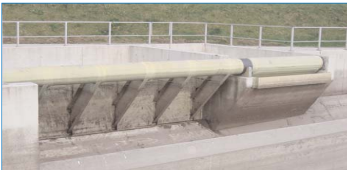
ASK-Wehr - Ansicht Oberwasser
