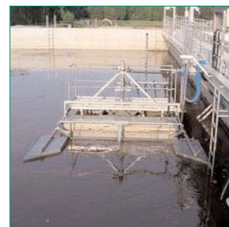
Wartungsplattform mit Sondenhalterung
