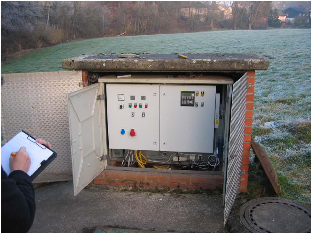
Umbau eines alten Schaltschranks
